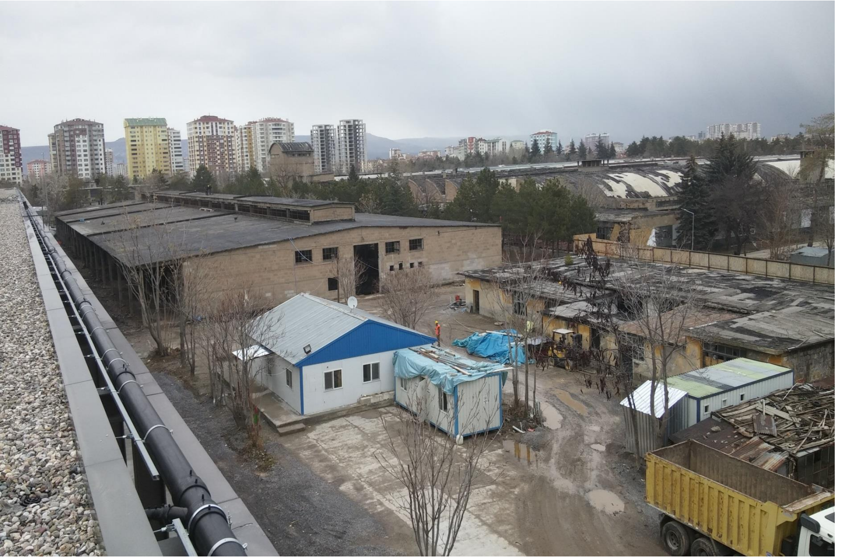
Mamul Ambarı ve İtfaiye Binası Eski Hali
